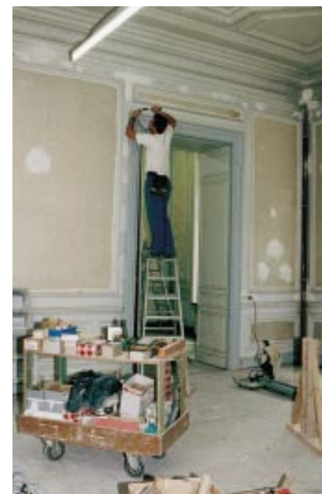
Rénovation du siège du Parlement bruxellois.
